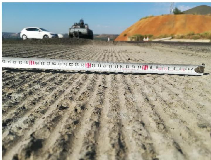
Figura 50. Detalle de la textura del fresado superficial. Fuente: Benito Arnó e Hijos SAU
