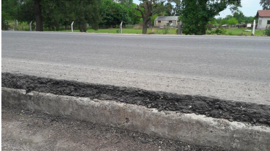
Figura 37. Vista lateral del espesor remanente de mezcla asfáltica
