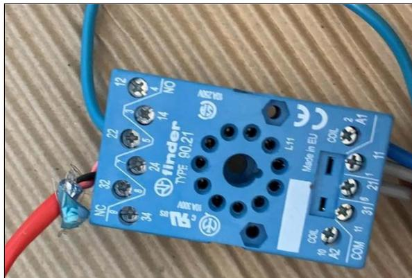
Figura 11: Zócalo de conexiones
