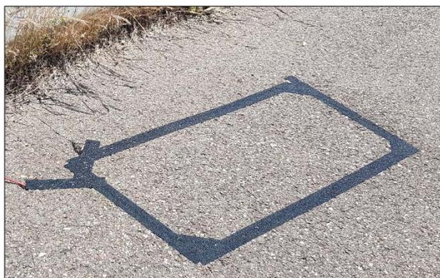
Figura 9: Geometría e instalación de lazo inductivo incrustado en el pavimento
